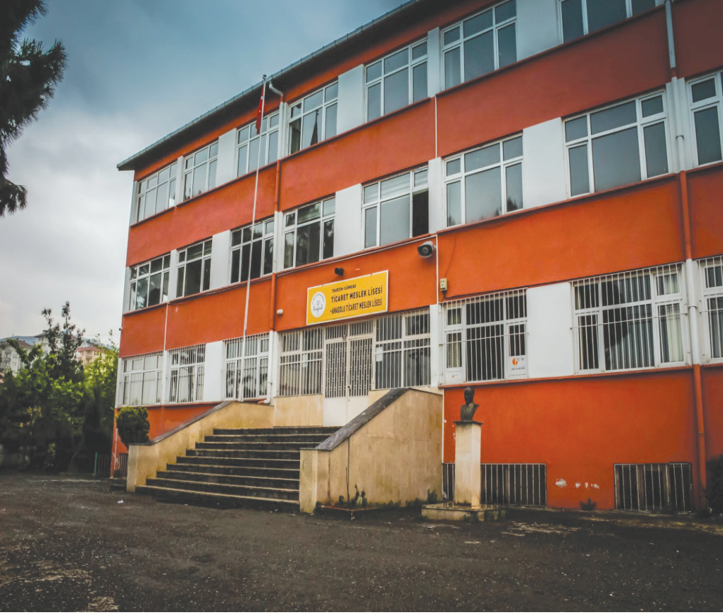
(Ek-9) Ticaret Lisesinin yapımı
