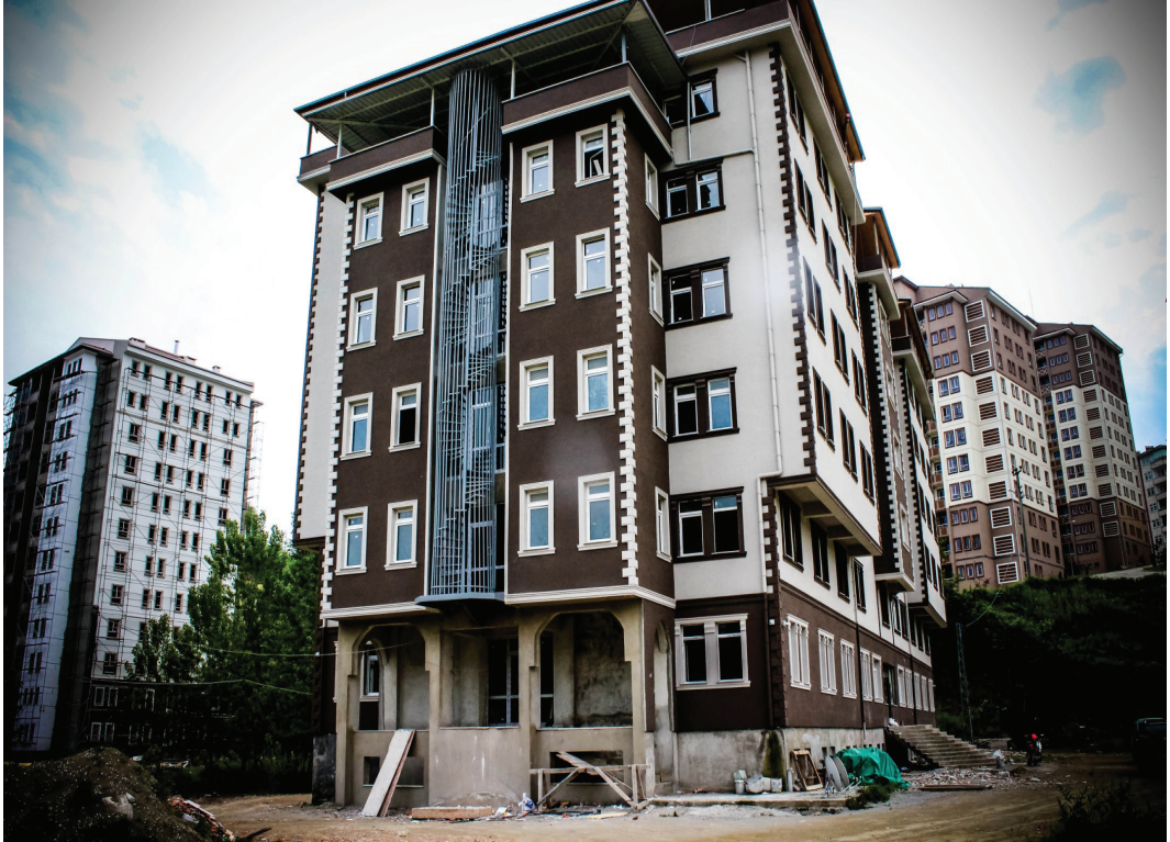
(Ek-16) Yedi katlı Bölge Yatılı Kur'an Kursunun binasının yapımı
