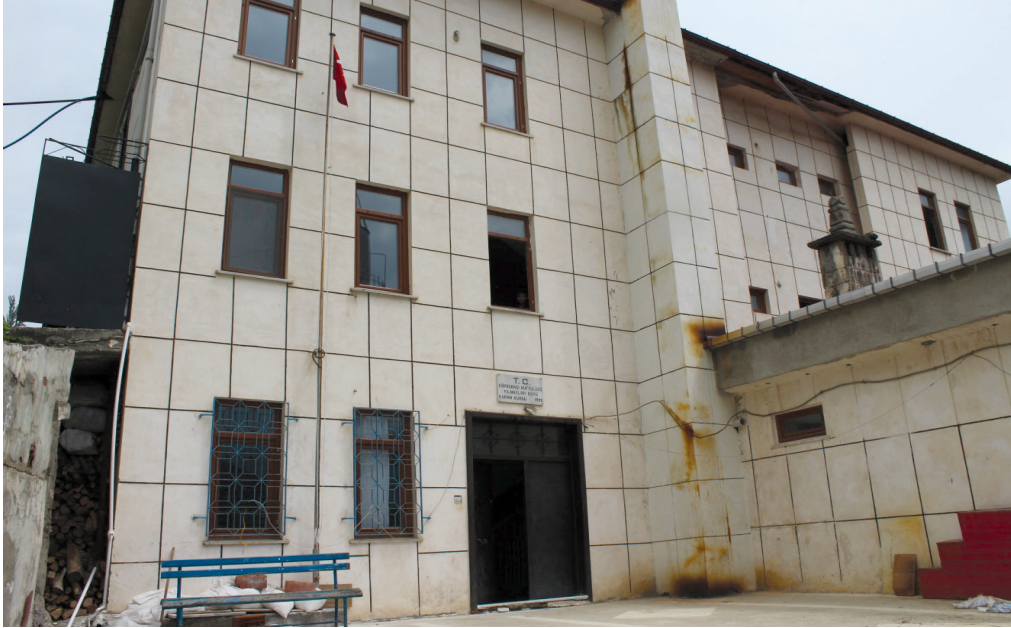
(Ek-10) Yılmazlar Mahallesindeki beş katlı yatılı Kur'an kursu binasının yapımı
