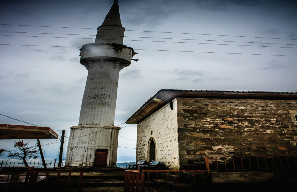
(Ek-13) Minarenin yapımı
