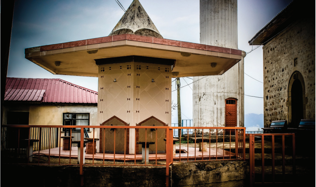
(Ek-14) Şadırvanın yapımı
