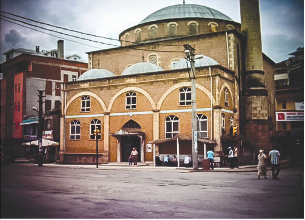
(Ek-7) Merkez Yeni Caminin yapımı
